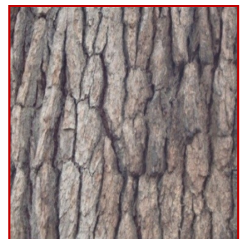
Longitudinal smooth cracks (5)
